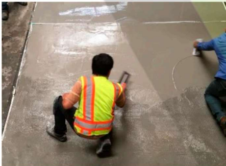
FIG. 1.7 COLOCACIÓN DE LEVEL FLOR
