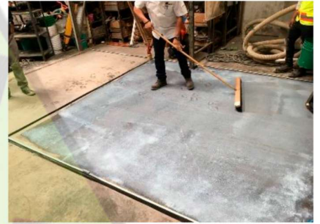
FIG. 1.6 COLOCACIÓN DE BASE ACRYLICA
