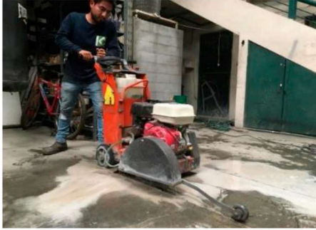
FIG. 1.1 CORTE Y RETIRO DE PISO DE CONCRETO VIEJO
