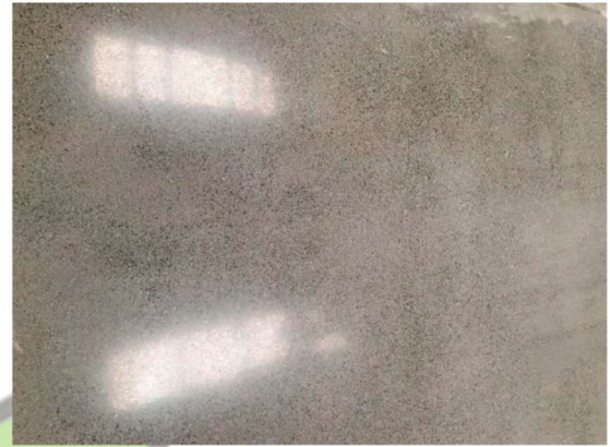
FIG. I.V ABRILLANTADO FINAL
