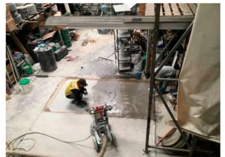
FIG. 1.15 PULIDO Y ABRILLANTADO DEL TRU PC
