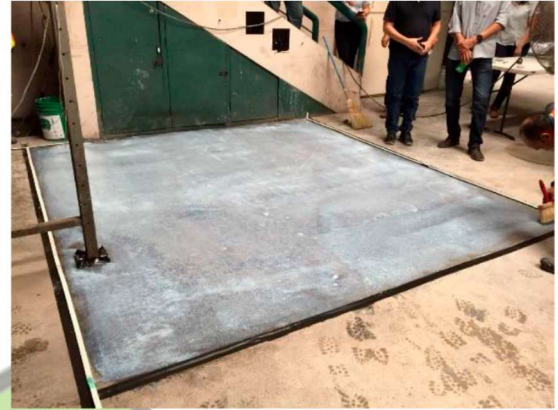
FIG. I.II APLICACIÓN DE PRIMER TXP™ FAST
