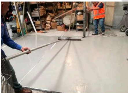
FIG. 1.10 COLOCACION DE TRU GRAY SELF LEVELING
