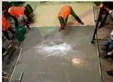
FIG. 1.11 COLOCACIÓN Y ACABADO DE TRU GRAY SELF LEVELING
