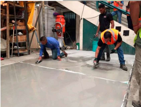
FIG. I.IV VERTIDO Y COLOCADO DEL LEVEL FLOR® Y TRU PC®
